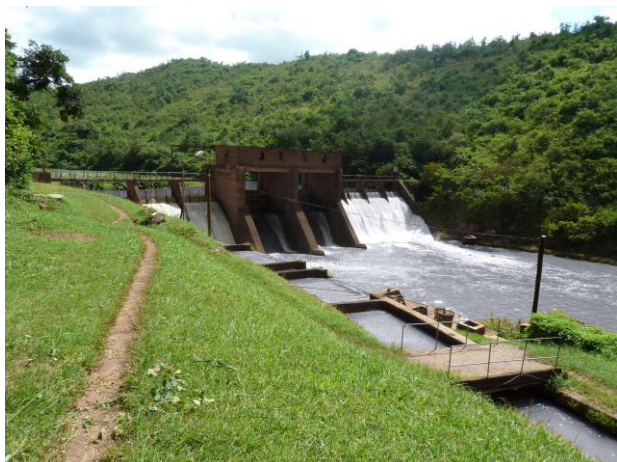
Bildunterschrift 2: Der Einlauf des Kleinwasserkraftwerks Wanjii in Kenia.
