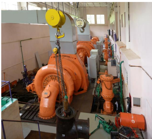
Bildunterschrift 1: Neue Turbinen, Generatoren und Leittechnik werden im kenianischen Kleinwasserkraftwerk für eine 20-prozentige Leistungssteigerung sorgen.
