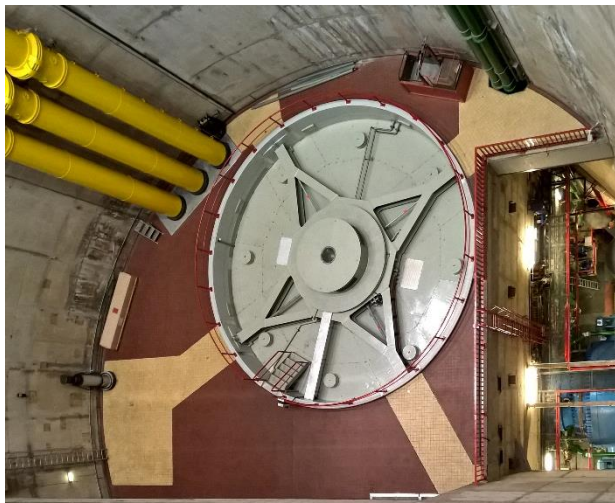
Bildunterschrift: Generator im Kraftwerkshausschacht im Pumpspeicherkraftwerk Vianden in Luxemburg.
