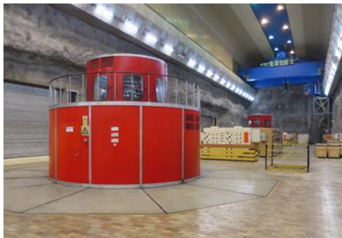
Bild 1: Voith's Maßnahmen am Kraftwerk Drakensberg reduzieren wir die Betriebstemperaturen und Schwingungen der Maschinen, sodass ihre Lebensdauer deutlich gesteigert werden kann.
