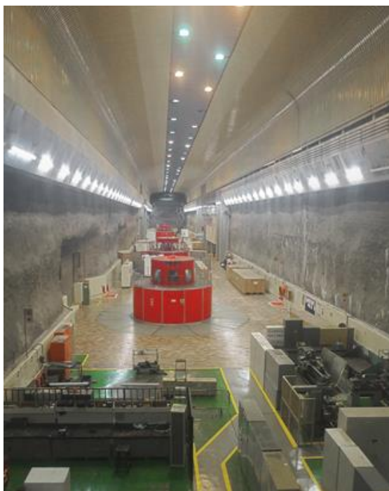
Bild 2: Das Wasserkraftwerk Drakensberg ist vollständig unterirdisch gebaut.
