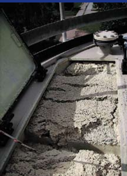
Sulkublokki reaktoripäässä
