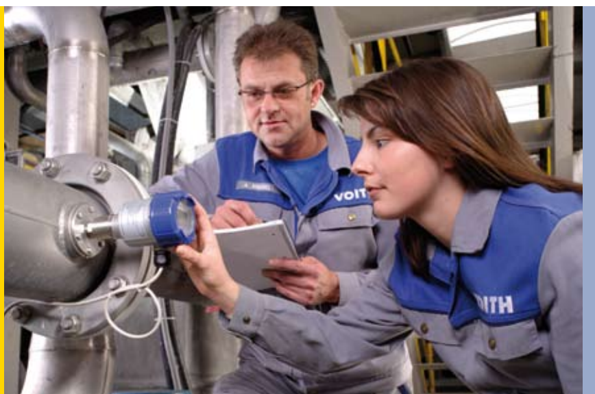
Kenttälaitteen valinta, toimitus, asennus, käyttöönotto sekä valvonta yhden toimijan vastuulla: OnC PressSens painelähtetimen toiminnan tarkastus.
