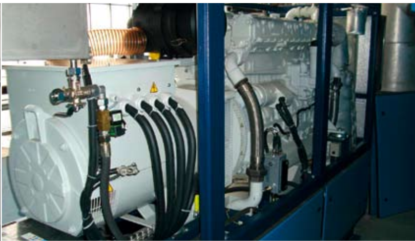
图 2 和 3：德国迪伦的组合发热与发电工厂每年可以出产 500MWh 电能。此外，管道绝缘的改善还减少了天然气的消耗（下图）。
