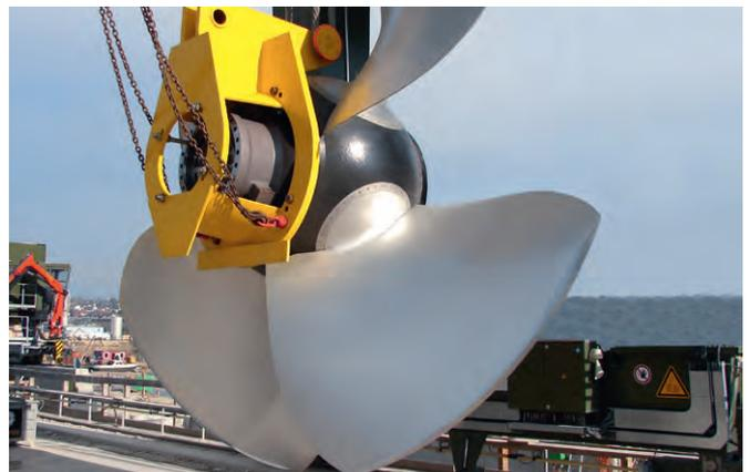
Einbau einer Turbine im Wasserkraftwerk Rheinfelden
