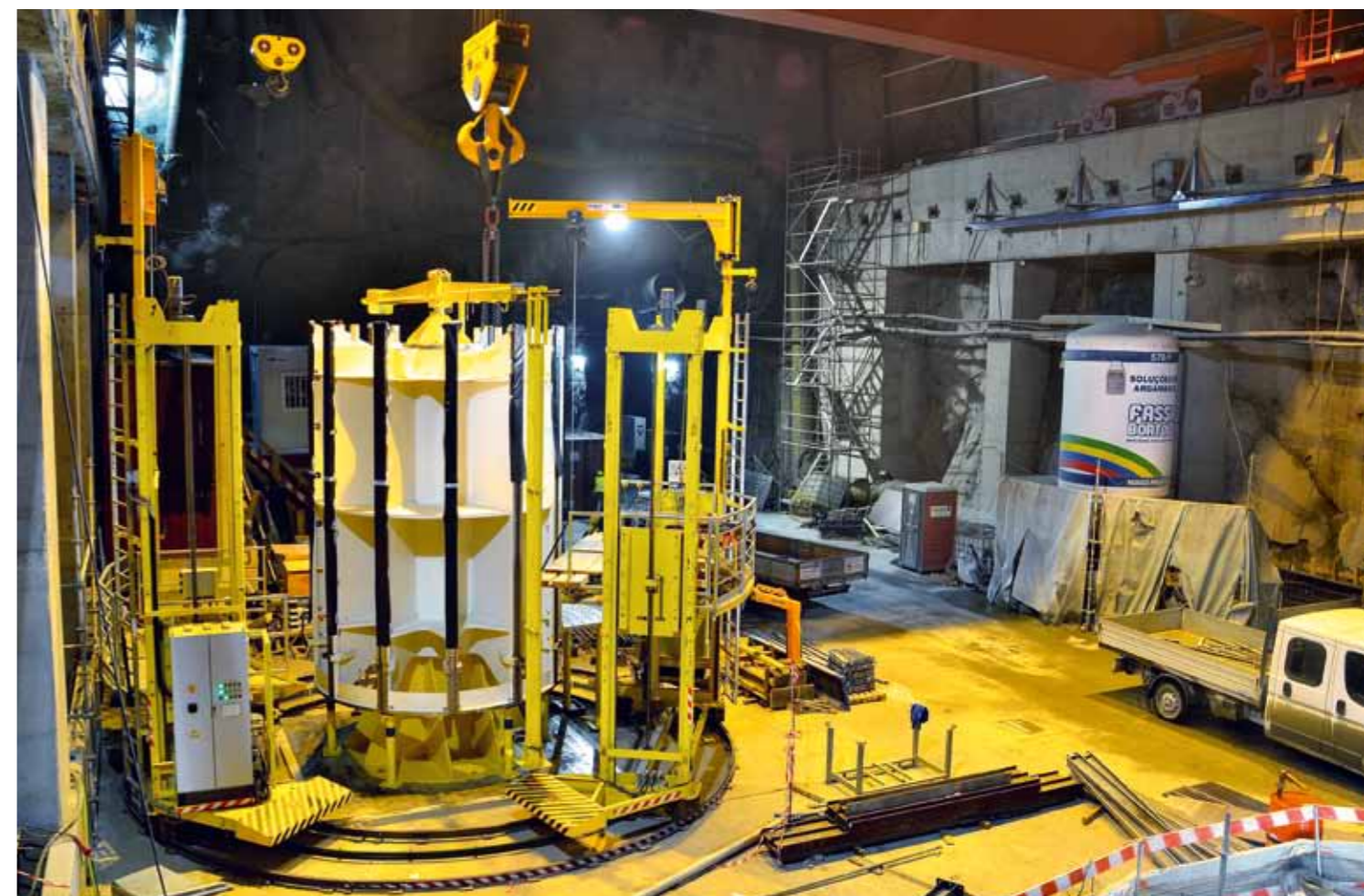
Rotornabe mit der neu entwickelten halbautomatischen Montageplattform auf dem Vormontageplatz, kurz bevor das Blechen startet.
