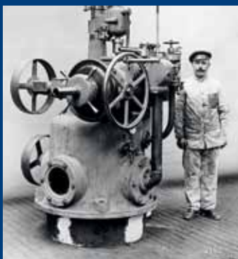
Primer regulador de turbina de Voith
