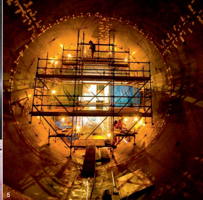
4 Inspeccionando a chegada de novos equipamentos: Marc Gagnon de pé dentro de uma das tampas das turbinas. 5 Trabalhadores dentro da caixa espiral, que é quase do mesmo tamanho que um túnel ferroviário subterrâneo.
