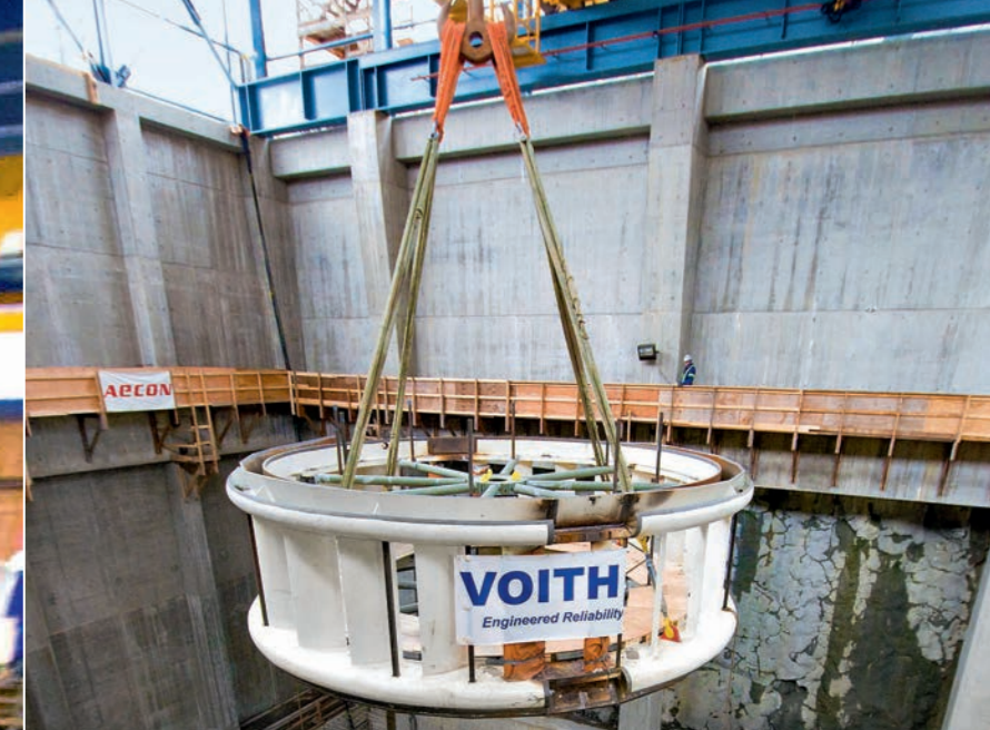
Descida do pré-distribuidor até o piso da turbina.
