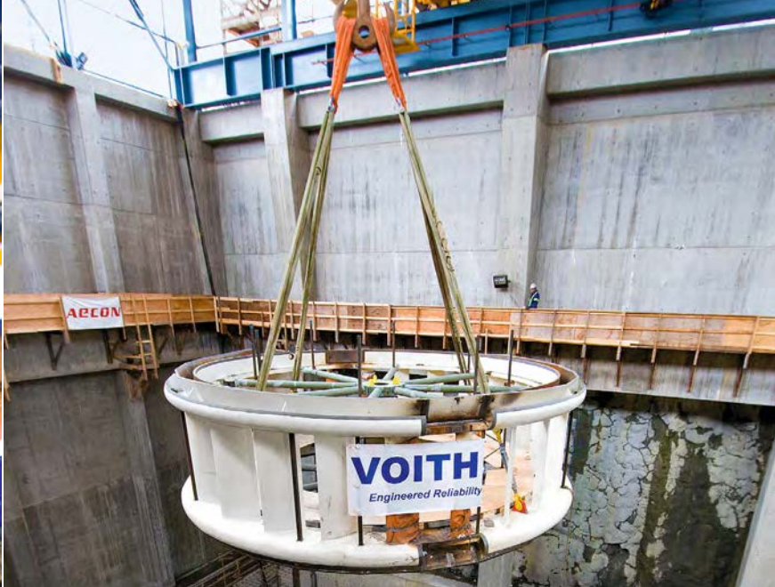
正在将座环吊入水轮机层
