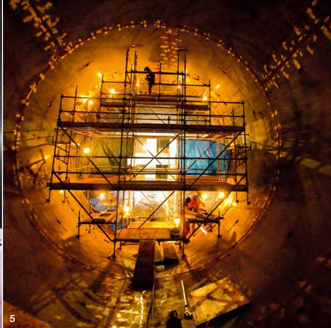
4 检查新到设备：Marc Gagnon正站在一个顶盖内 5 蜗壳内的工人们（该蜗壳的大小相当于一座地下火车隧道）
