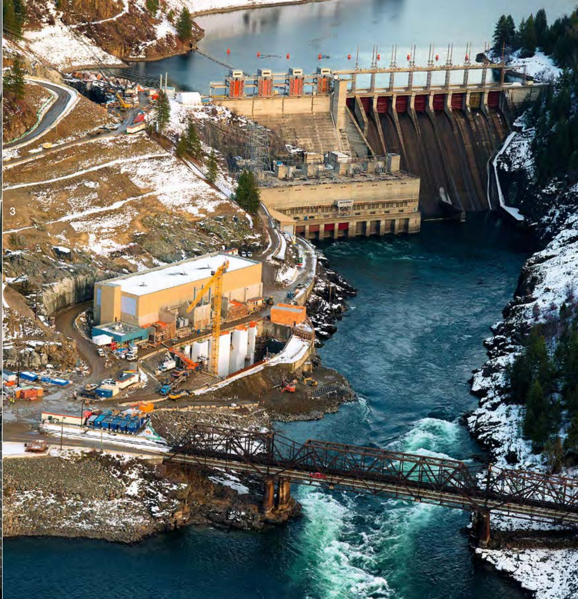
1 近观Waneta电站安装的水轮机转轮 2 Waneta发电厂第二机组（Unit 2）定子安装 3 俯瞰庞多瑞河Waneta扩建工程
