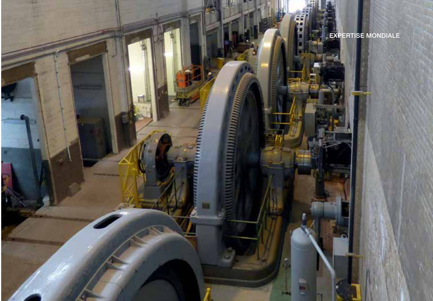
Amélioration de pièces d'origine : Voith a remis à neuf des composants datant de 1920 à Pointe du Bois.
