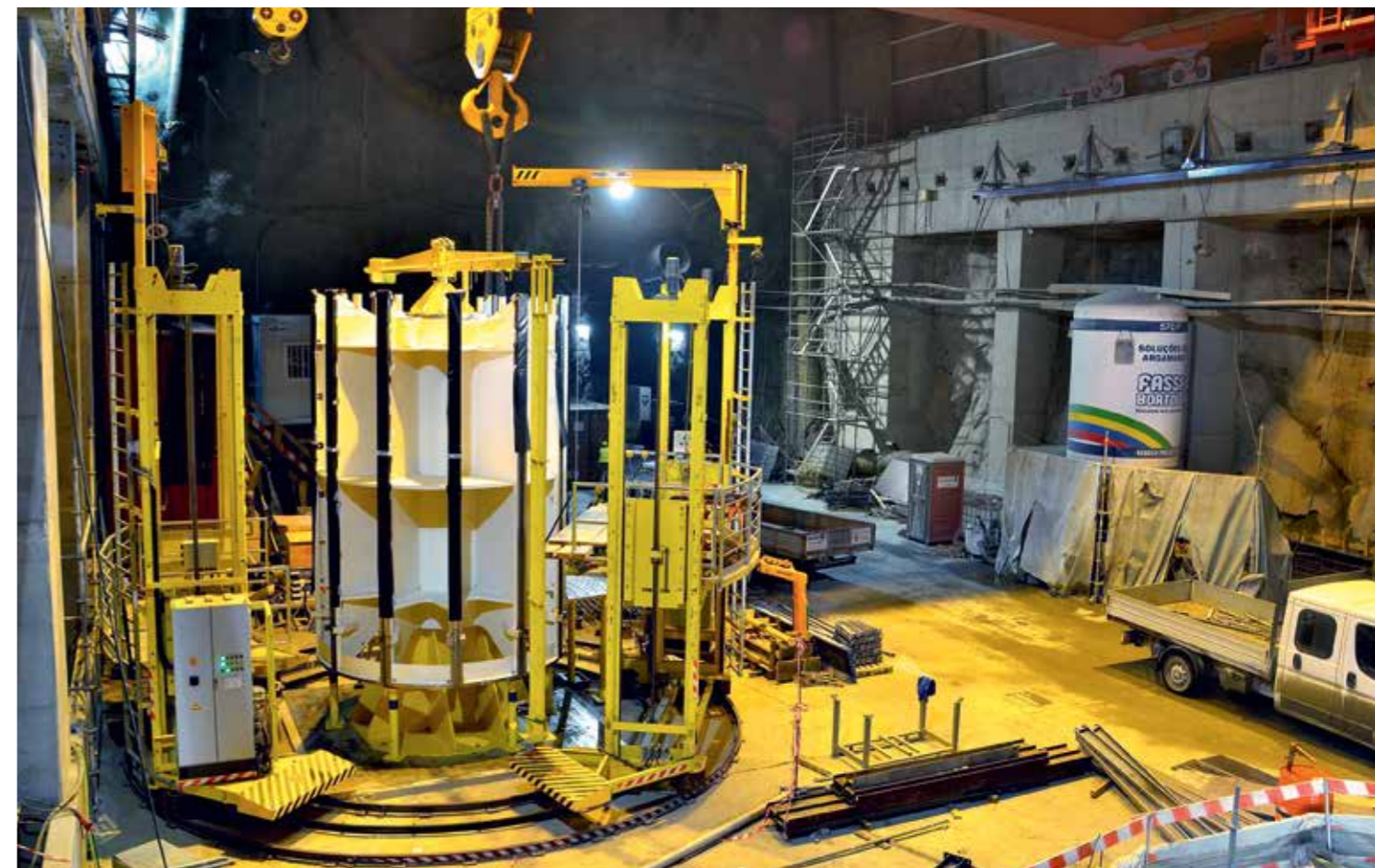
Le moyeu de rotor avec la nouvelle plateforme d'empilage semi-automatique sur les lieux de préassemblage, peu de temps avant le début de l'empilement des tôles.
