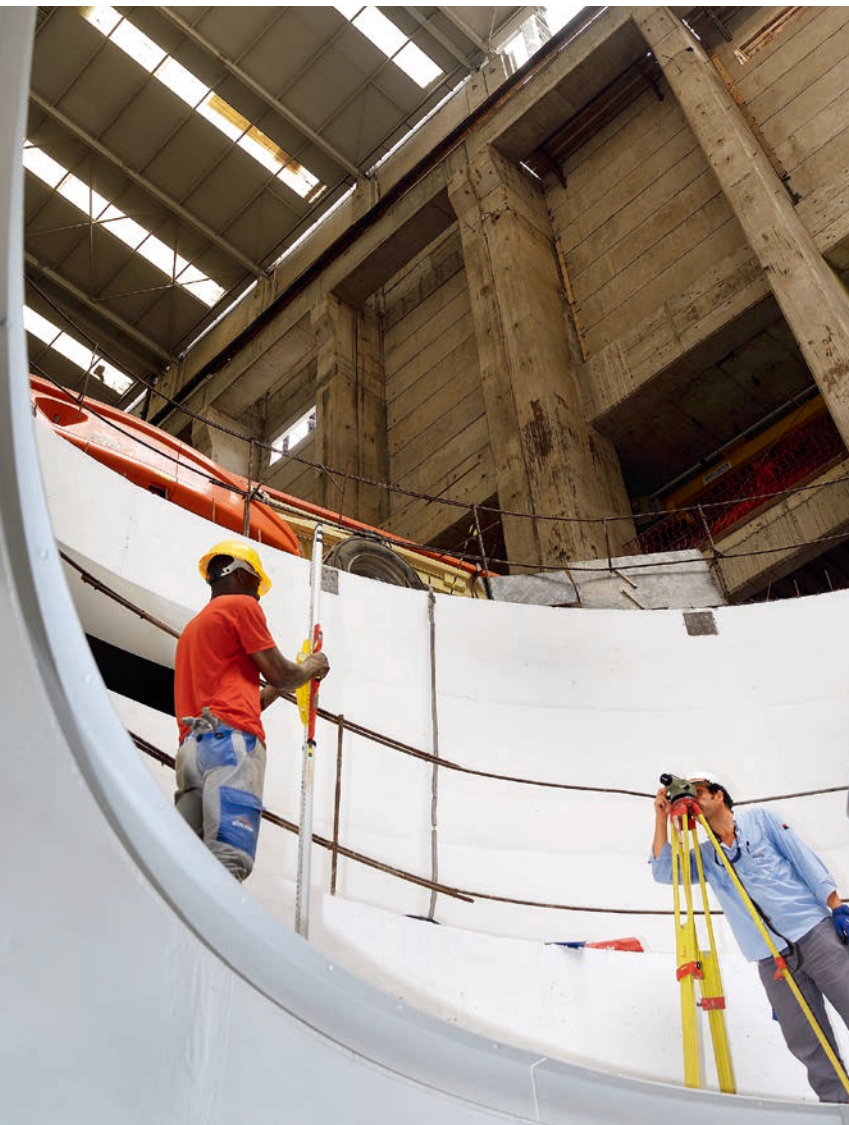
カンバンベ第二発電所の発電機ピットを計測する作業員。
