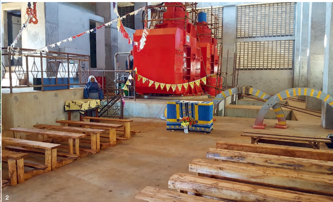
1 トウリラの流れ込み式水力発電所。 2 コミッショニング当日の新しい機械。
