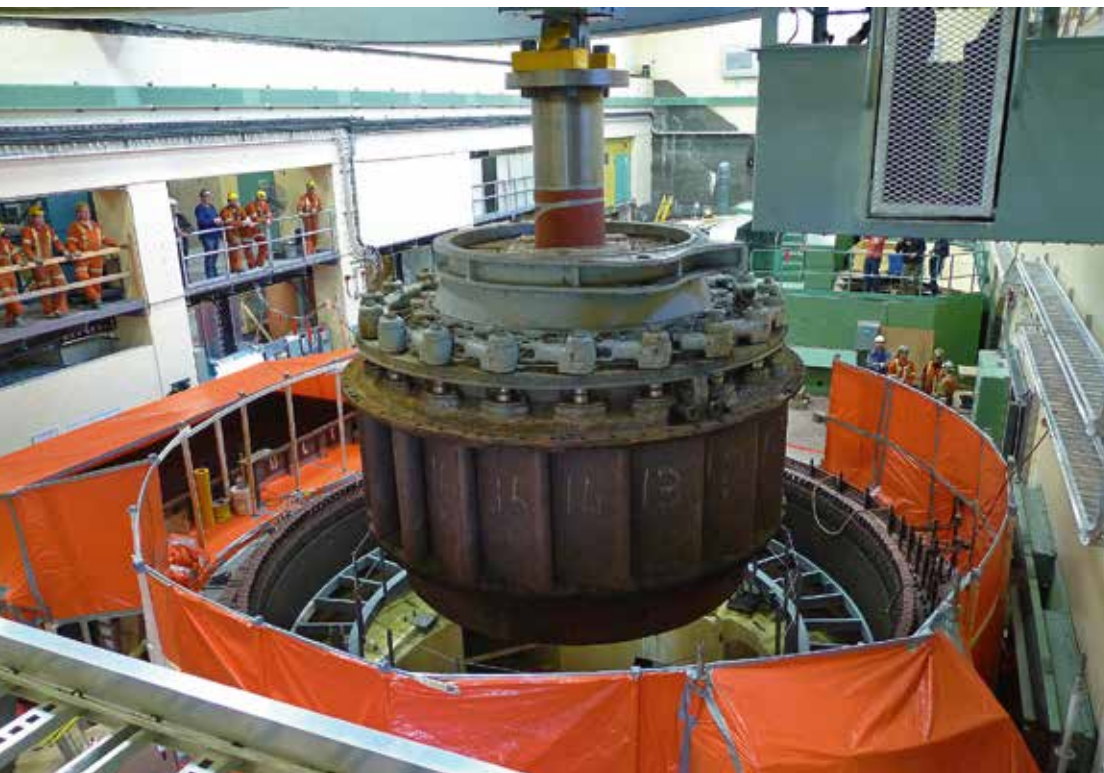
Remoção do distribuidor da turbina na casa de força de Rapides-des-Quinze, em Quebec, no Canadá.
