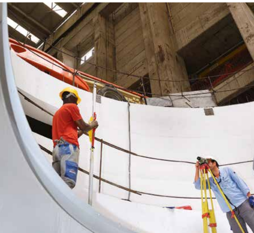
Montadores medem o poço de um dos geradores na casa de força de Cambambe II.
