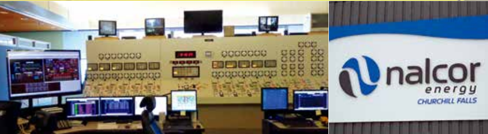
丘吉尔瀑布拉布拉多有限公司决定对丘吉尔瀑布服务年限超过40年的控制系统进行更新。得益于信息量的增加，电子自动化将使电站实现优化运行。
