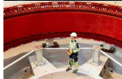
2014年建成后，布达豪斯发电站将拥有95MW的装机容量。
