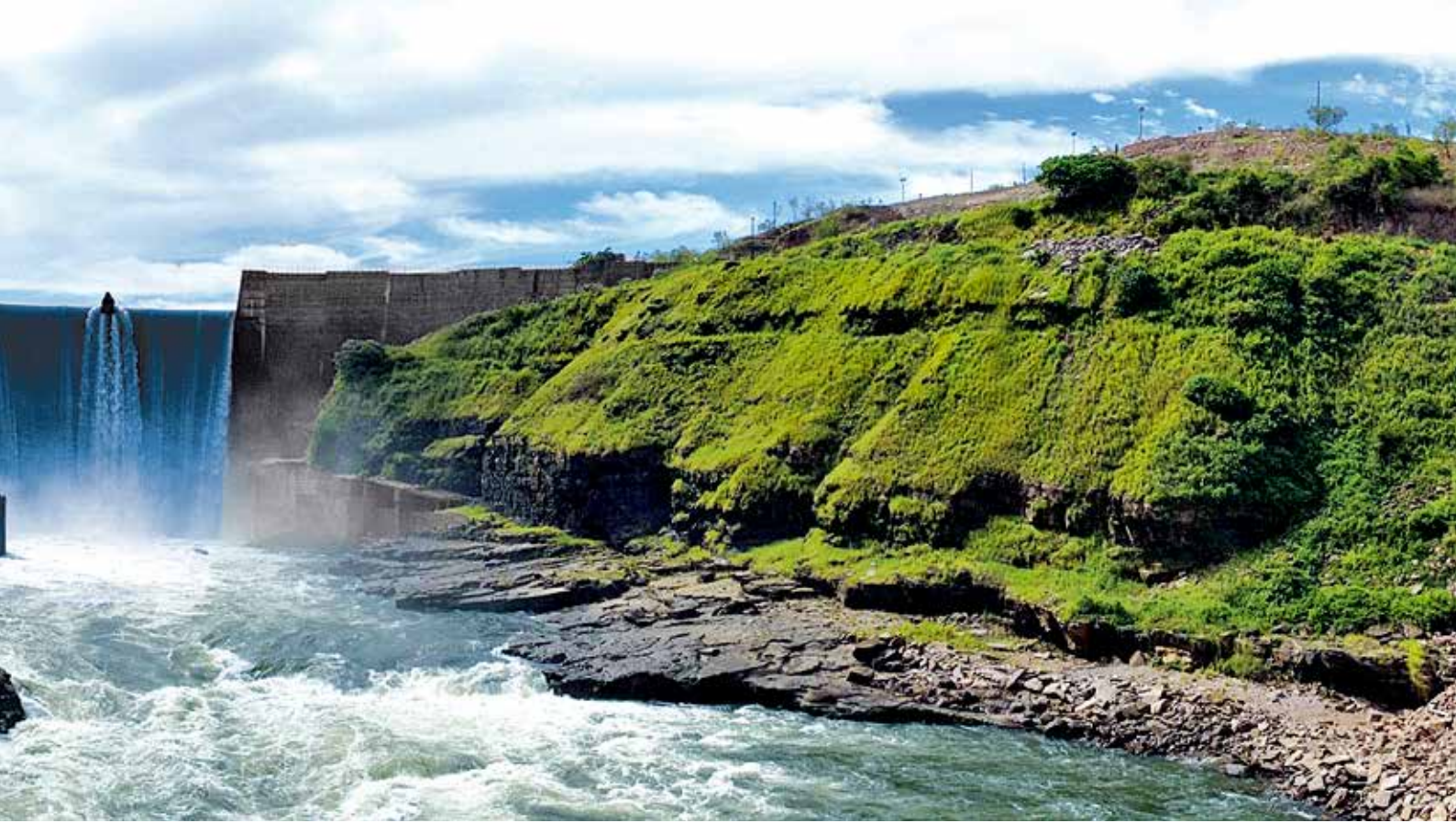
福伊特已为宽札河上的坎班贝水电站完成重大升级工作。目前，该地区的第二个水电站正在规划中。
