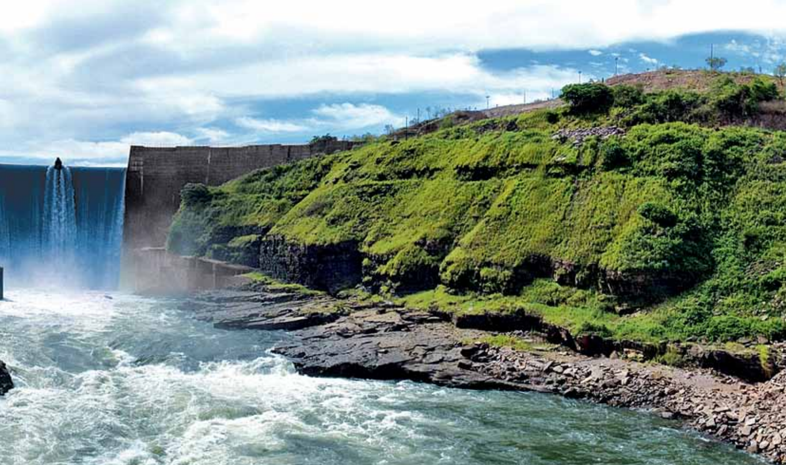
A Voith completou uma grande modernização na usina de Cambembe, no rio Kwanza. E agora está sendo planejada uma segunda usina.
