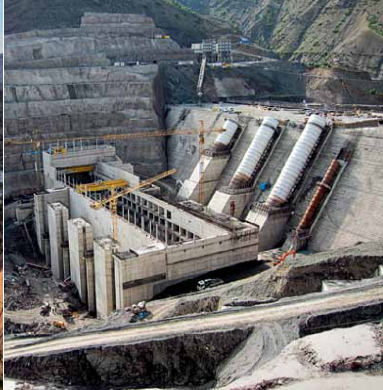
Beyhan I é a primeira de quatro usinas hidrelétricas a serem instaladas nesta área do rio Murat. A Voith Hydro está equipando a usina com três geradores.
