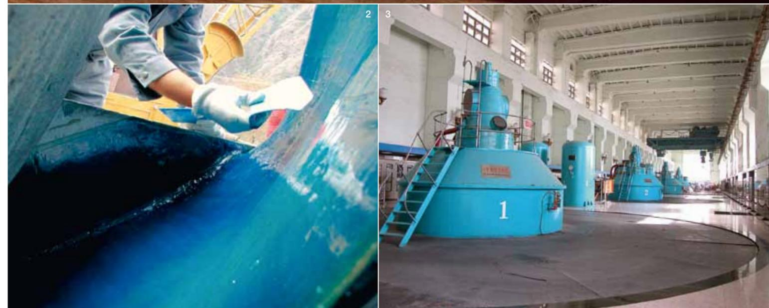
1 et 2 Le revêtement polymère SOFTURB offre une excellente résistance contre l'abrasion. On peut l'appliquer par les méthodes conventionnelles, avec un pinceau ou par pulvérisation, par exemple.
