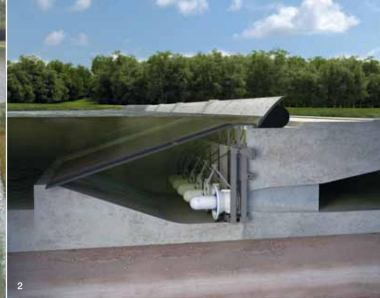
1 Installation type d'une centrale électrique avec StreamDiver
