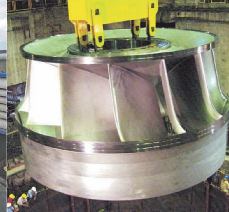
Rotor Francis em aço inoxidável ASTM - A743 CA6NM, sendo colocado no poço de operação. Peso: 300.000 Kg
