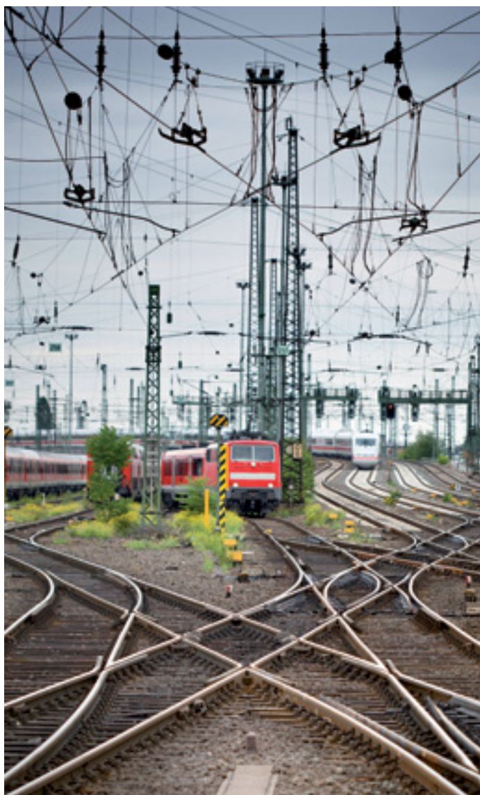
La empresa Deutsche Bahn es el mayor consumidor de electricidad de Alemania y requiere una red de distribución propia y especial.
