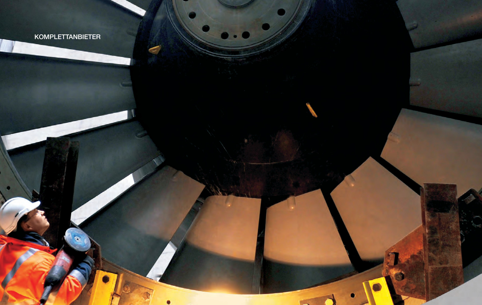
Leitschaufel des umfassend modernisierten Wasserkraftwerks Rheinfelden an der schweizerisch-deutschen Grenze.
