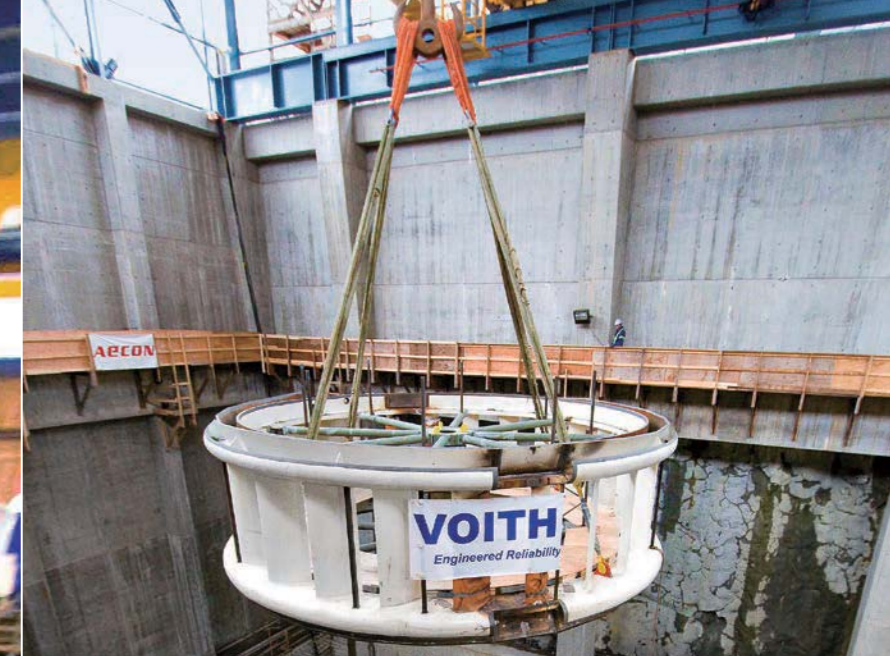
ステータリングを水車フロアに降ろす
