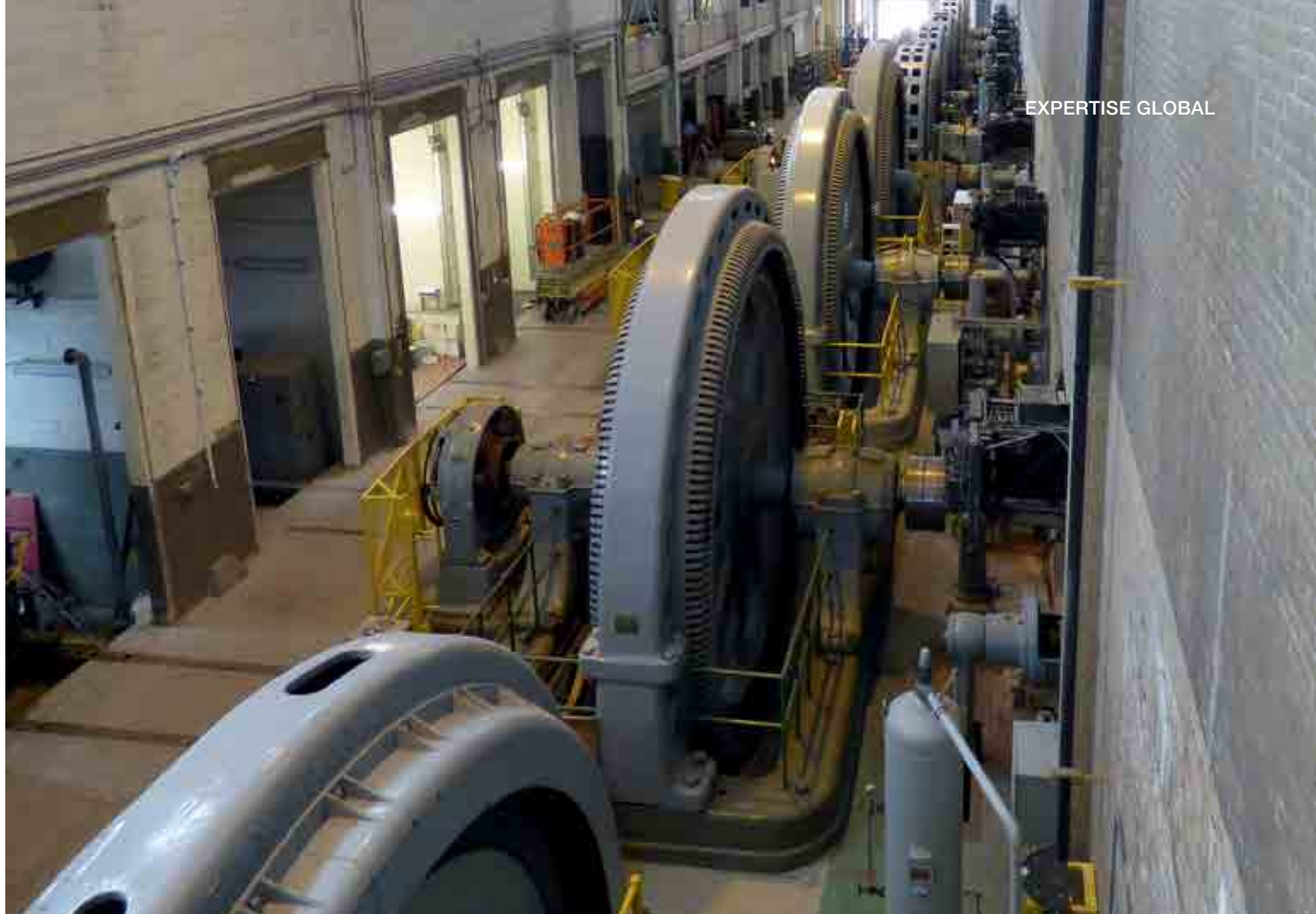
Original reconcondicionado: Componentes da década de 1920 recuperados pela Voith em Pointe du Bois.
