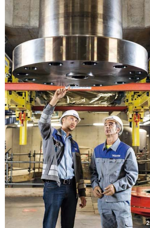
1 ガイドベーン操作機構の据付作業
