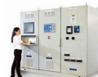
自動制御システム
