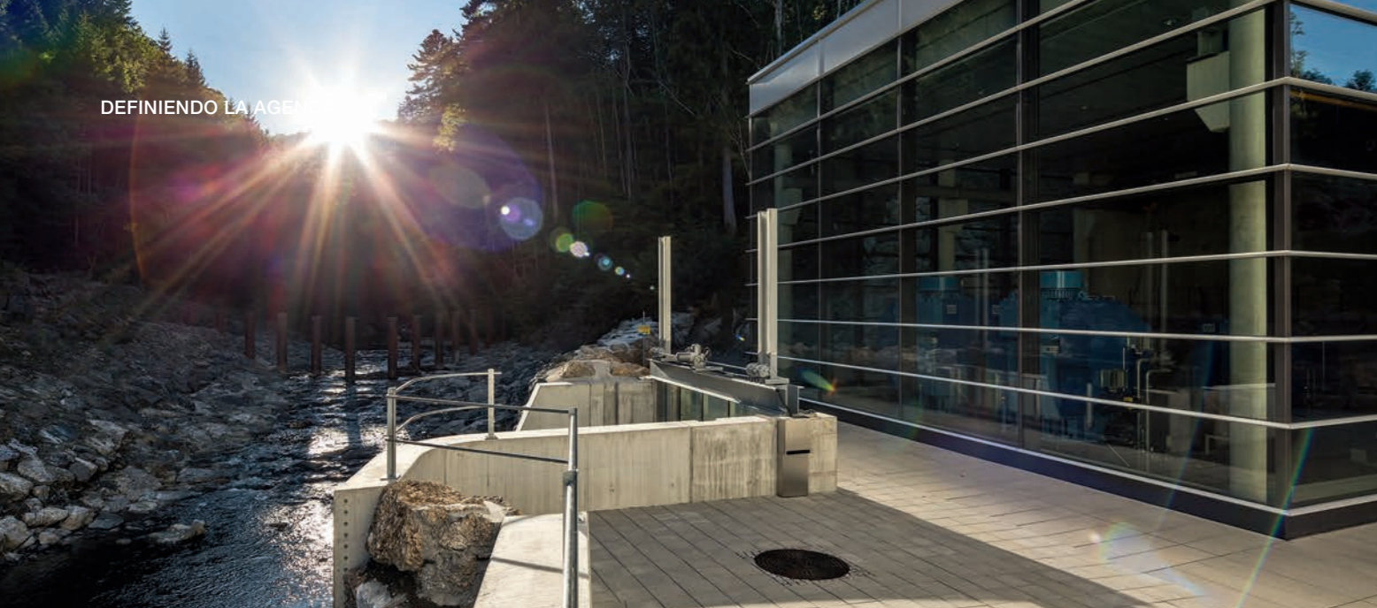
Esta pequeña central hidroeléctrica en Blaiachach, Alemania, incluye una solución ecológica para drenar el flujo de la toma de agua.
