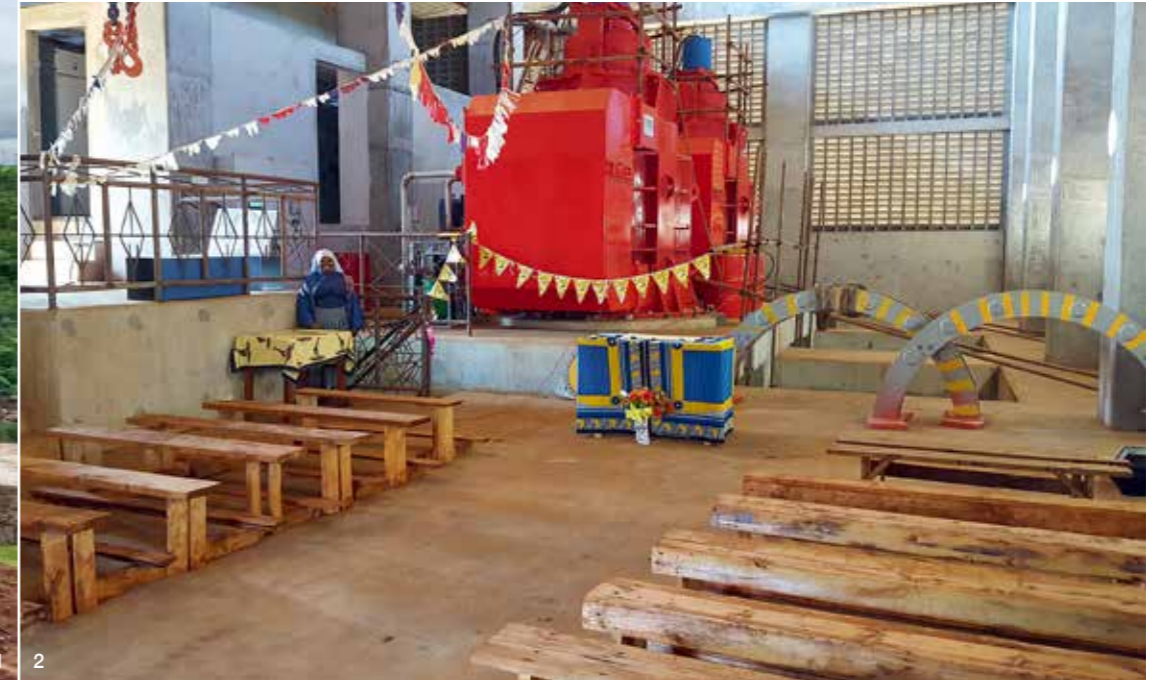
1 位于图里拉的径流式电站 2 新机器投入运行之日
