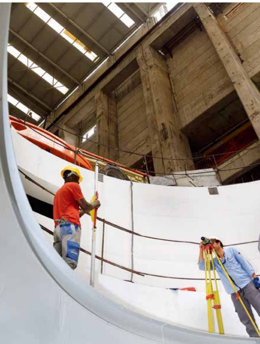
工人在坎班贝II站主厂房实施发电机坑测量
