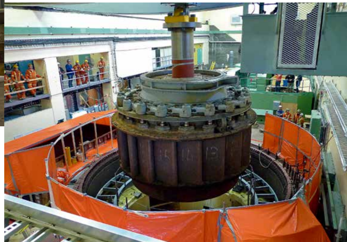
一台水轮机的导水机构从加拿大魁北克省Rapides-des-Quinze电站的主厂房移出。
