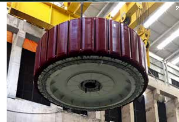
1 建设中的坎班贝二期水电站主厂房 2 新发电机安装
