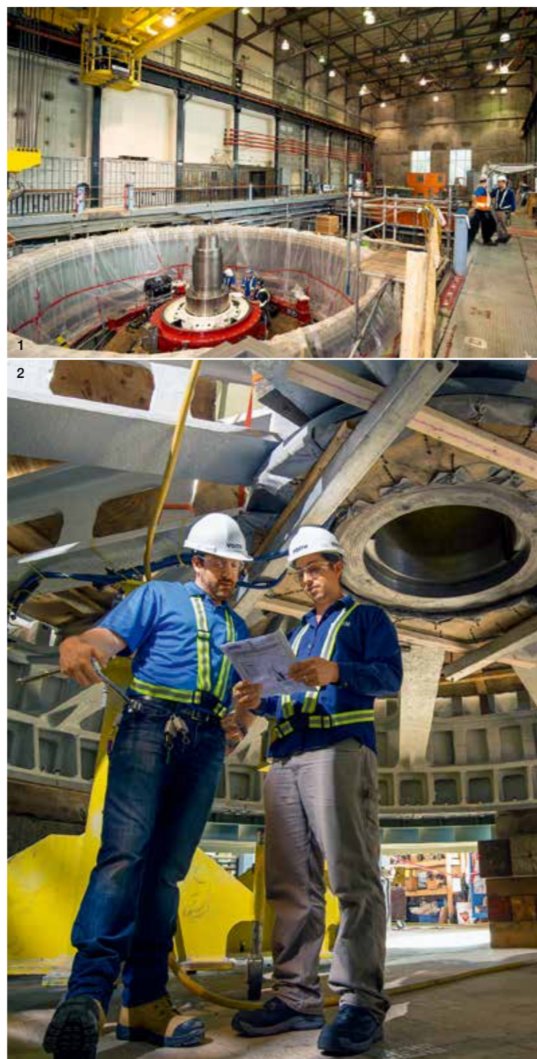
1 拉斯肯电站主厂房十分狭窄——对于拆卸和组装都是一个很大的挑战 2 福伊特工程师在项目之初即进行了深度检查
