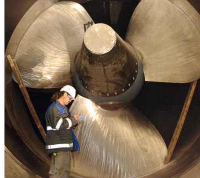
Les turbines puits Kaplan de Litoměřice : les plus grandes du genre d'Europe.
