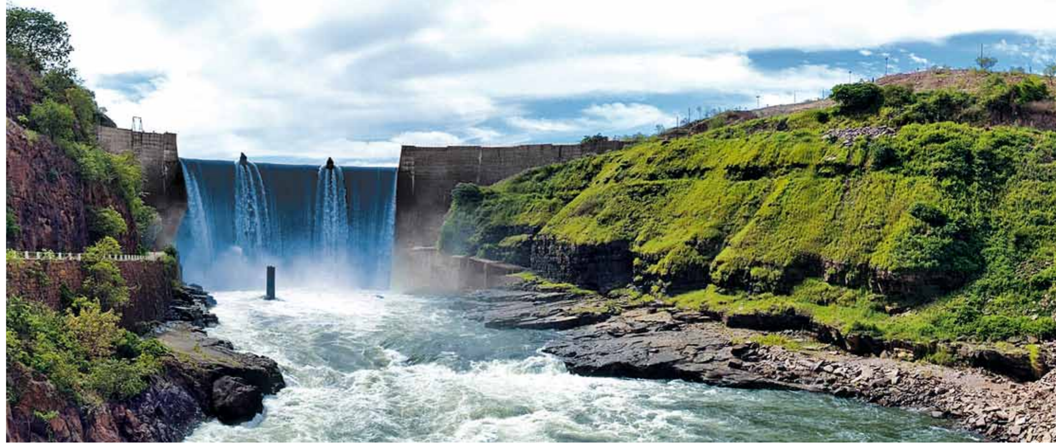
Voith a réalisé une réfection majeure à la centrale de Cambambe, sur la rivière Kwanza. Voilà qu'aujourd'hui une seconde centrale est prévue pour cette région.
