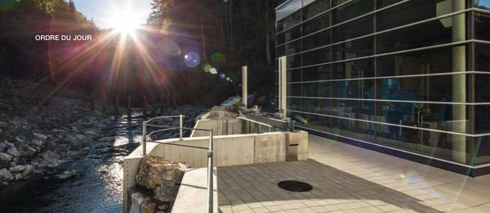
Cette petite centrale hydroélectrique située à Blaichach, en Allemagne, est dotée d'un drain de débit écologique.
