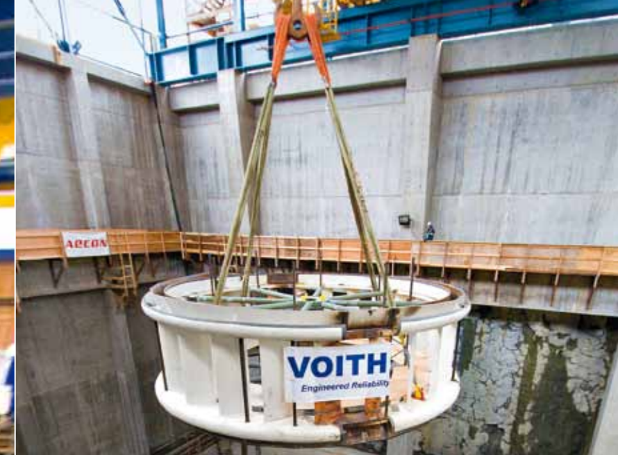
L'avant-distributeur est abaissé au plancher de la turbine.
