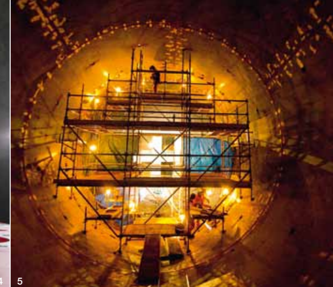
4 Inspection de l'arrivée d'un nouvel arrivage d'équipement : Marc Gagnon debout à l'intérieur de l'un des fonds supérieurs. 5 Des travailleurs à l'intérieur de la bache de la turbine, laquelle est presque aussi grande qu'un tunnel de métro.
