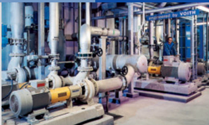
Kuva 6: AP 2000 konsepti sekoituspumpuineen.
