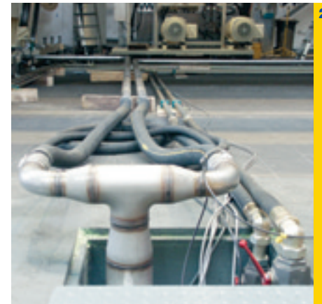
Abb. 2: Hydraulikzuleitung zur Anbindung des Janus MK 2 an das Versorgungsaggregat des Nipco Walzen Funktionsprüfstands.
