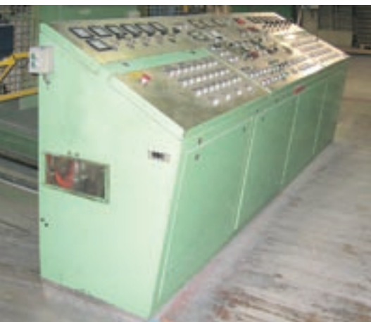
改造之前的控制台
