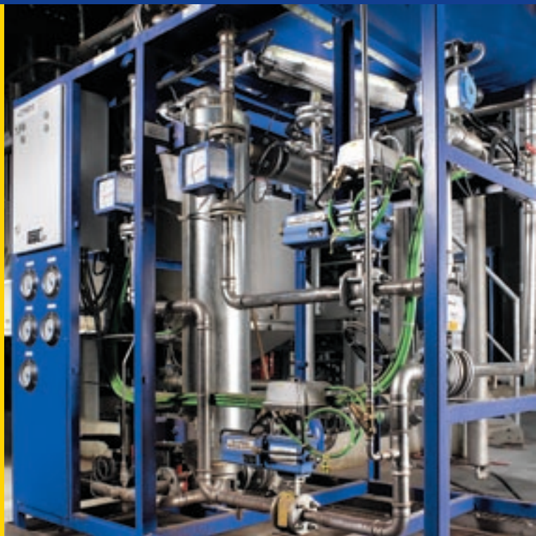
ModulePro C 的供水站
