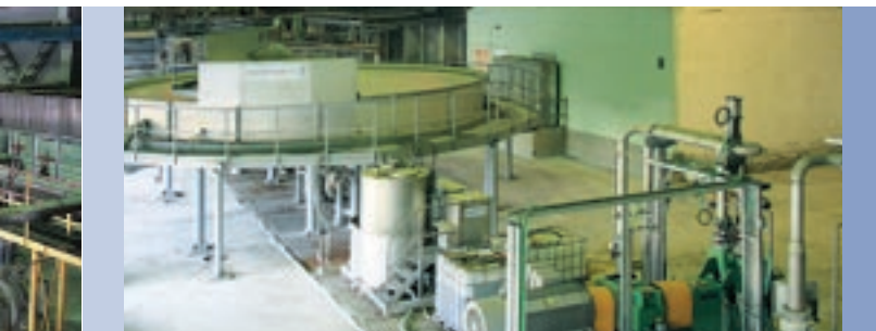
改造之后 从同一个视角看 到的景象: 新的 盘磨机和增装 的水处理
