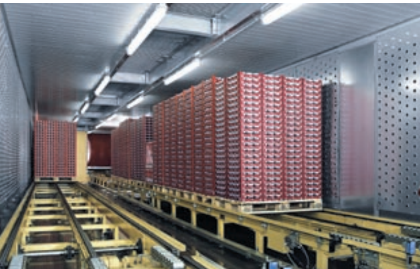
往复式冷却隧道(内景)
