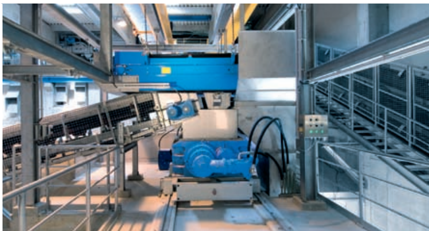
Измельчение сырья и удаление металла – необходимые условия сжигания отходов с высокой теплотворной способностью
