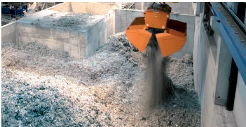
Самодвижущиеся краны с интеллектуальным управлением подают отходы из бункера на вторую ступень обработки, в системы смешивания и транспортировки.
