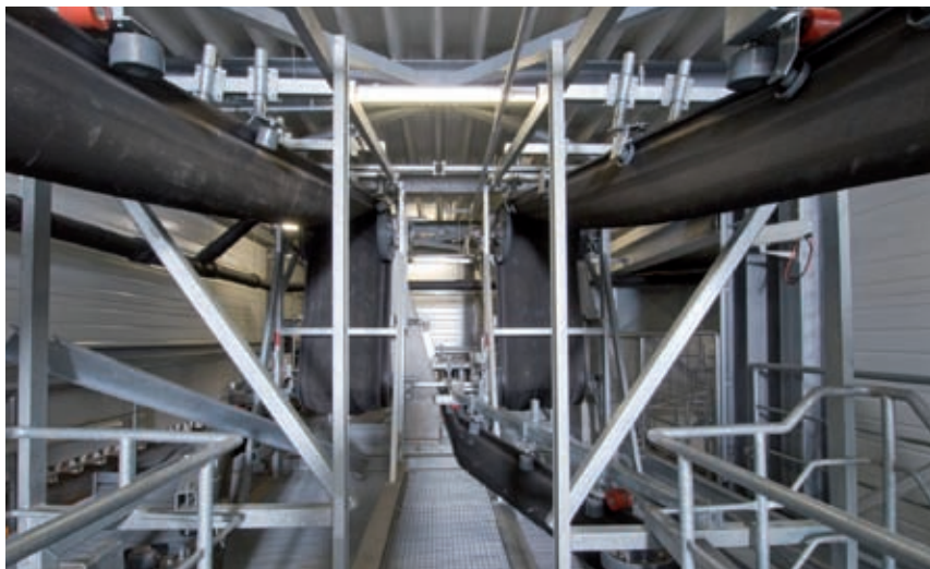
Закрытый ковшовый конвейер позволяет транспортировать топливо даже по сложным трассам.
