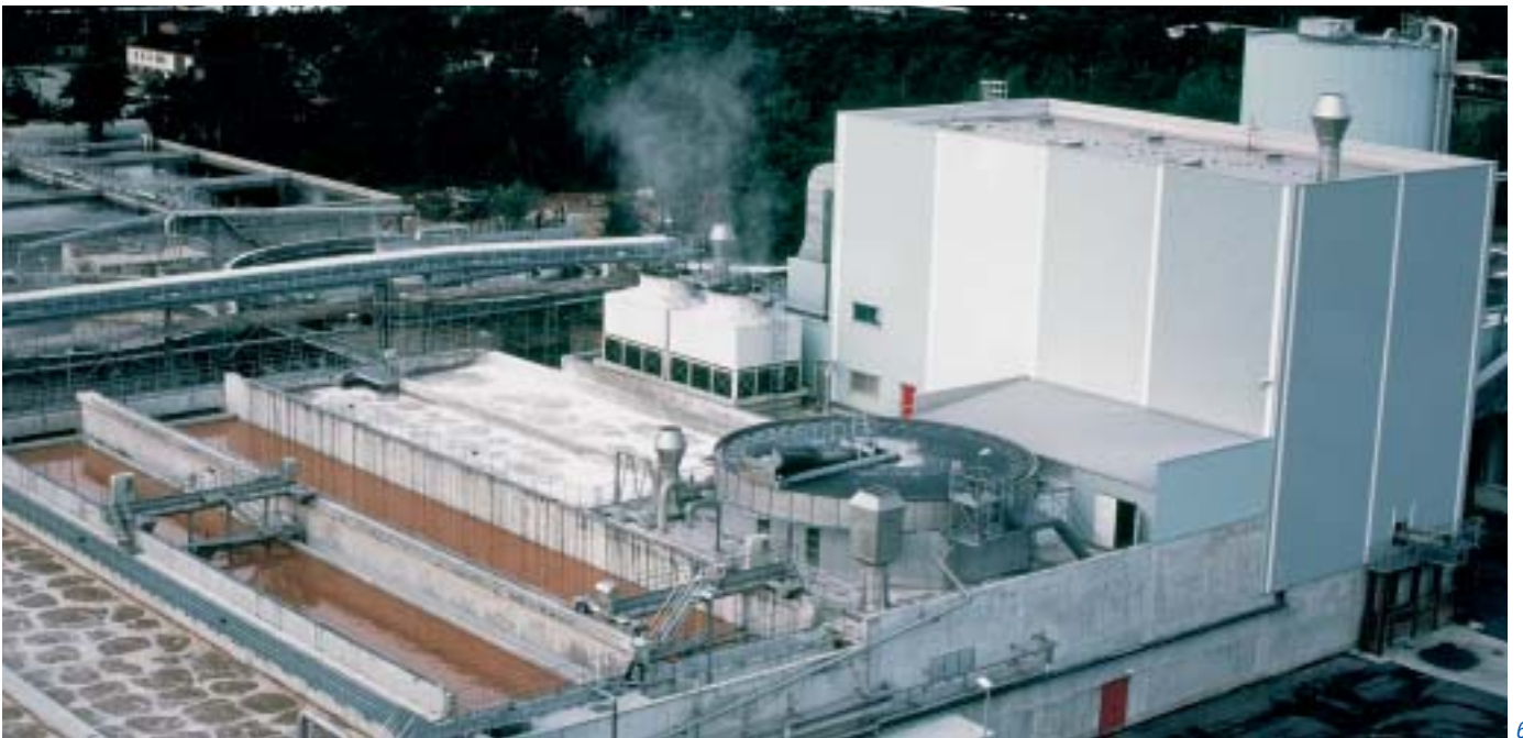
Abb. 7: Mikroflotation, eingesetzt zur Kreislaufreinigung und Filtrateindickung in einer Deinking-Anlage.
