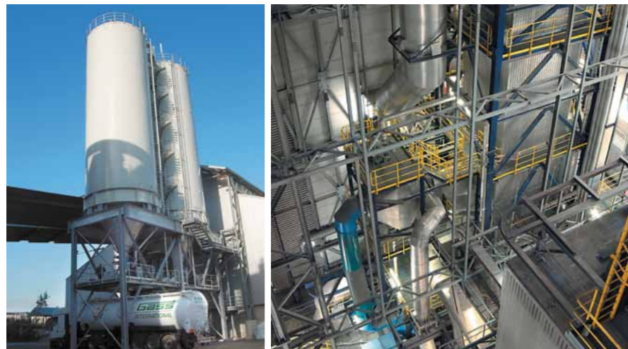
Рис. 3 и 4: В городе Дюйвен, Нидерланды, 200 000 тонн шлама от производства бумаги ежегодно перерабатывается в реактивные минеральные вещества.
