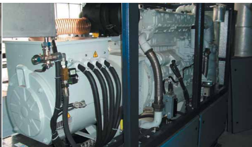
Рис. 2 и 3: Когенерационная установка в Дюрене, Германия, вырабатывает почти 500 МВтч электроэнергии в год (вверху). Кроме того, за счет усиления теплоизоляции трубопроводов снизилось потребление природного газа (внизу).
