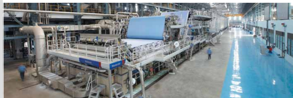
Новая БДМ-3 обеспечивает увеличение производственных мощностей TNPL. 18
