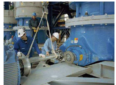
Installation der Voith SafeSet-Kupplung mit Zahnanschlusskupplung
