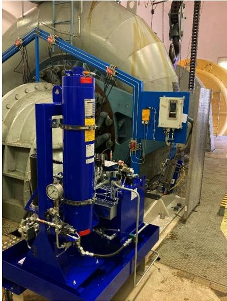
*Der HyCon GoHybrid in Betrieb im Wasserkraftwerk Nain.*
