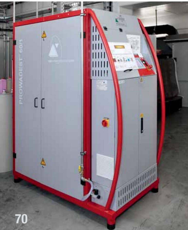
Abb. 1: 200 t/Jahr weniger Emulsionsabfälle ermöglicht die Vakuumdestillationsanlage in Heidenheim, Deutschland.
